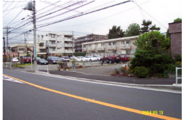
歩道は傾いたまま・切り下げ延長も常識はずれの長さ。 歩行者の用に全く意識が向いていない。
